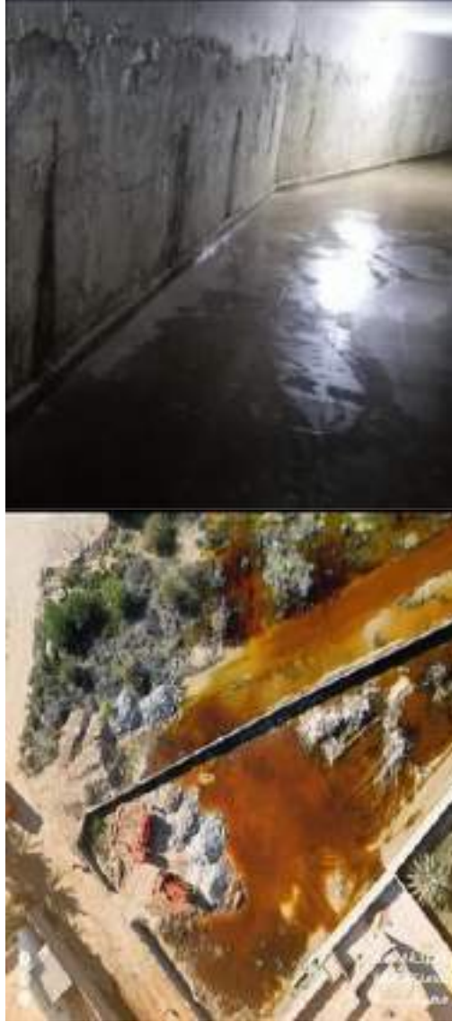
الشكل (6). تظهر المياه الجوفية على مستوى السطح.
